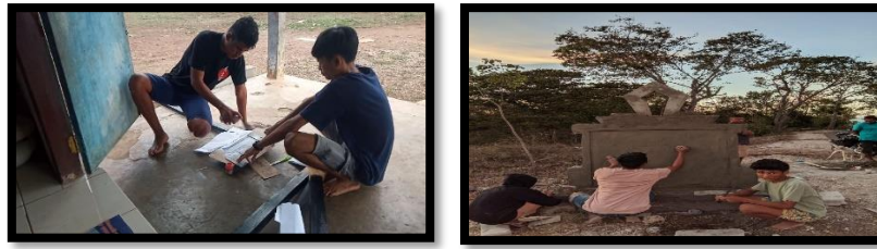
Gambar 4. Proses pembuatan plang pengenalan Dusun, RW, RT, Tugu tapal batas Desa serta proses pemasangan di Desa Maubokul
